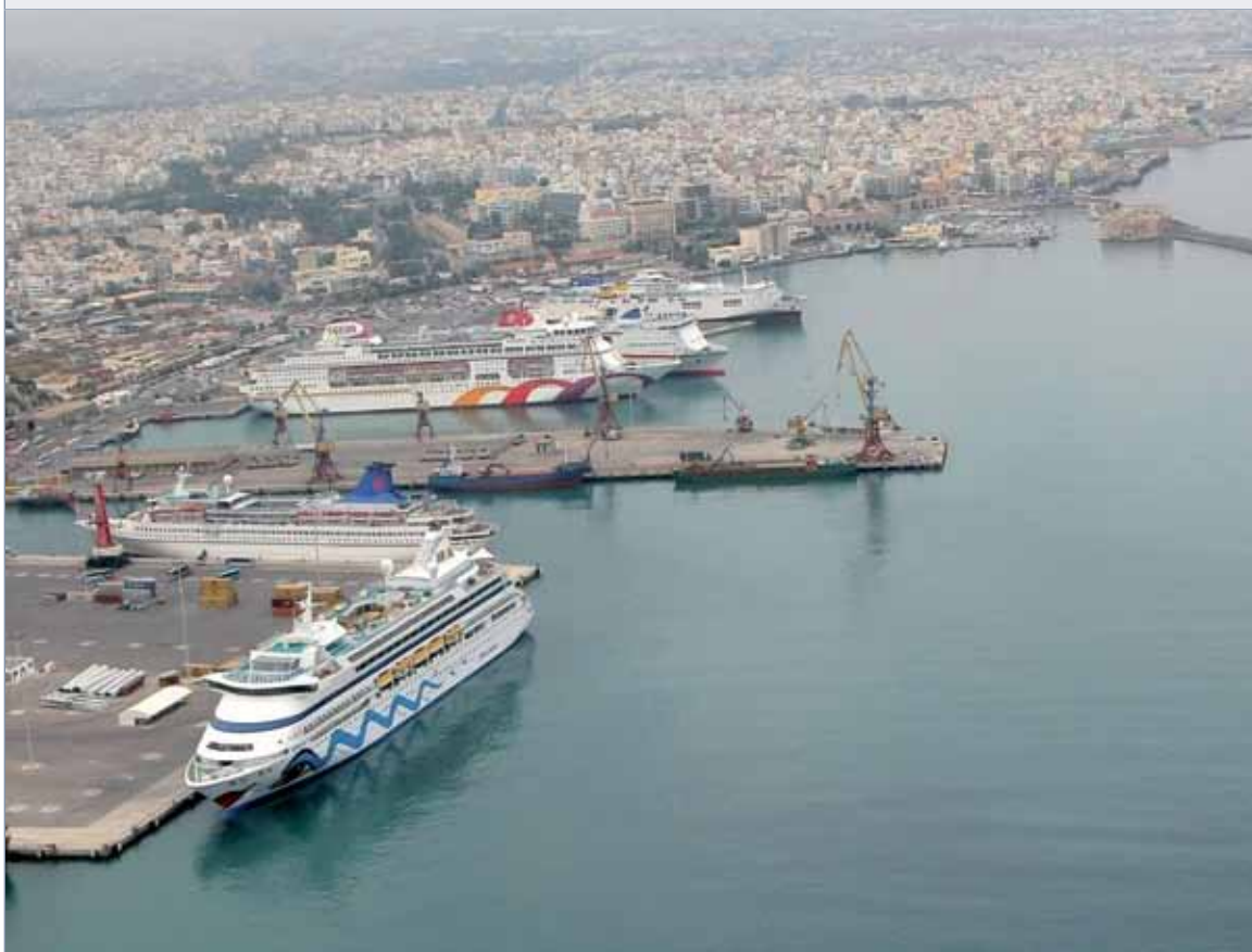
ΦΩΤΟΓΡΑΦΙΑ 2 Αεροφωτογραφία του λιμένος Ηρακλείου (κοιτάζοντας δυτικά)
